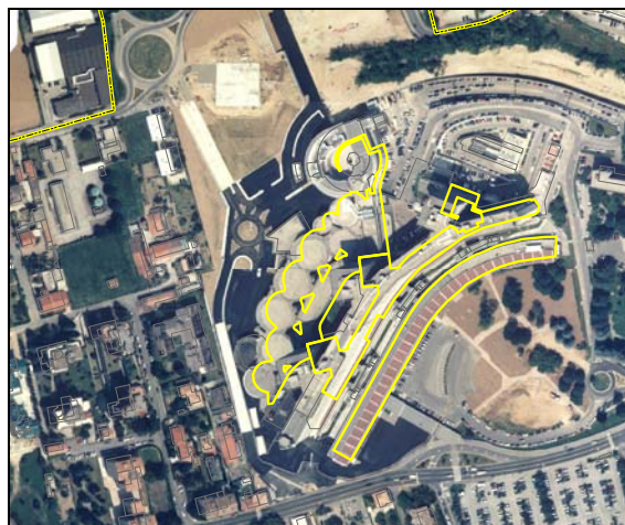
Edifici 2, 3, 4 e 5 – Ospedale Nuovo San Gerardo
