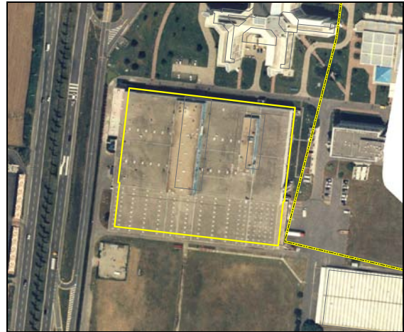
Edificio 2 – Industria Roche
