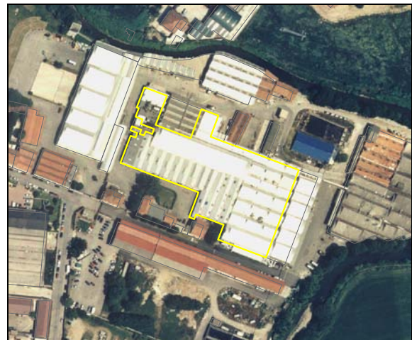
Edificio 4 – Industria Garbagnati
