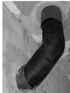
2) disaccoppiamento realizzato con guaina isolante
