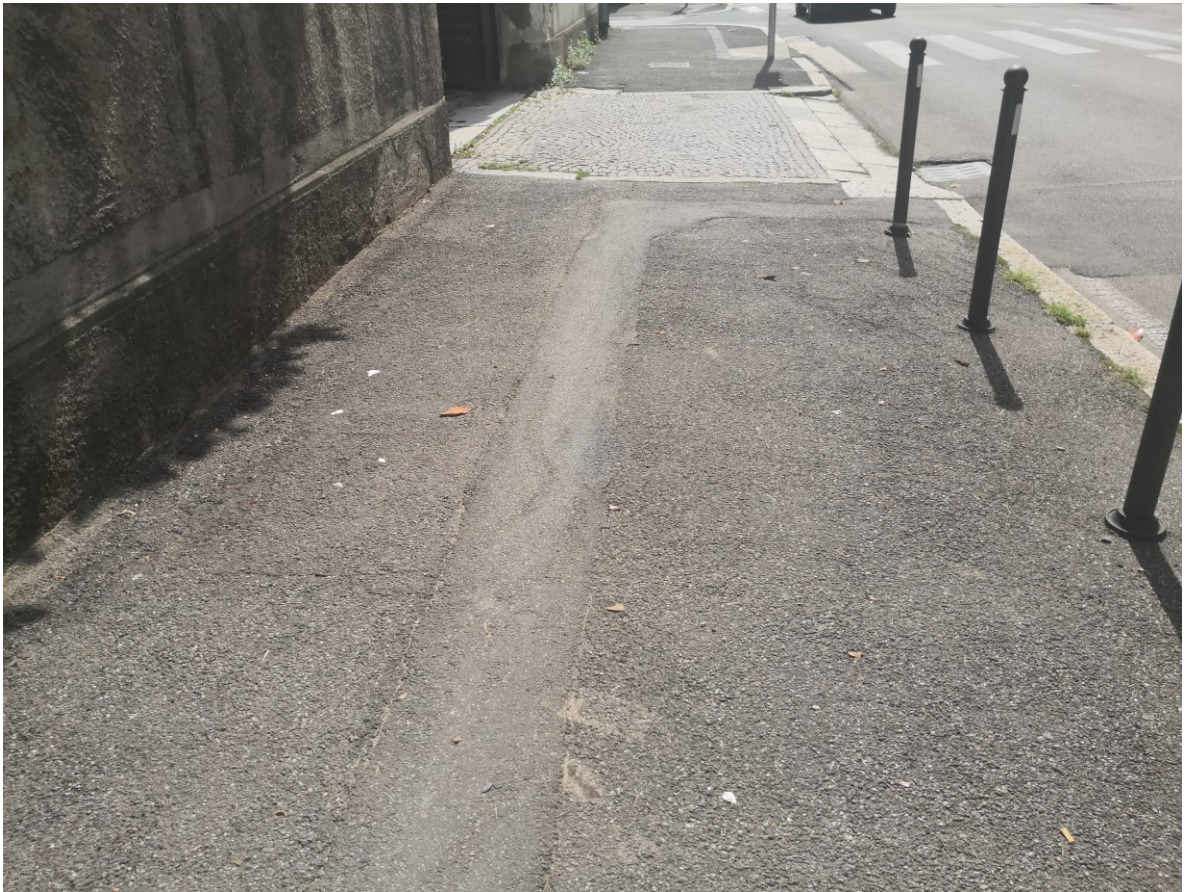
Foto 4: Marciapiede lungo via Lecco
