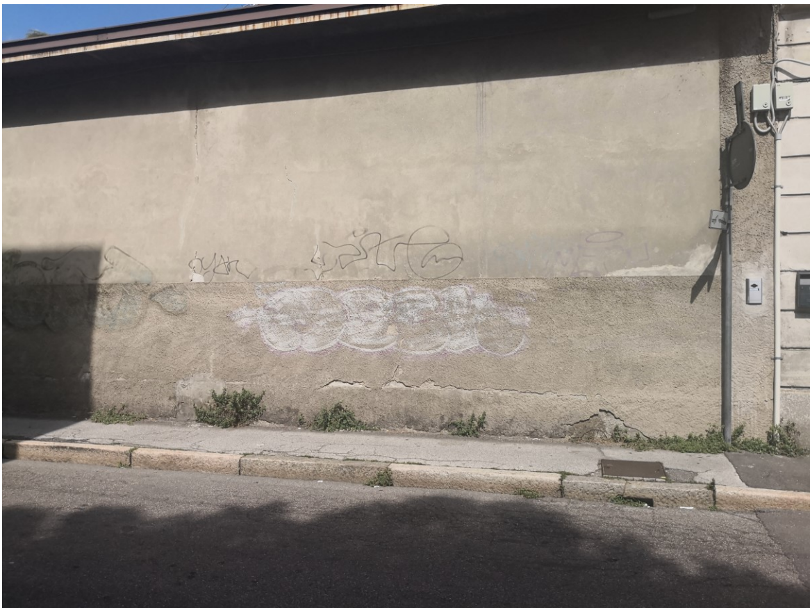
Foto 7: Marciapiede via Merelli
