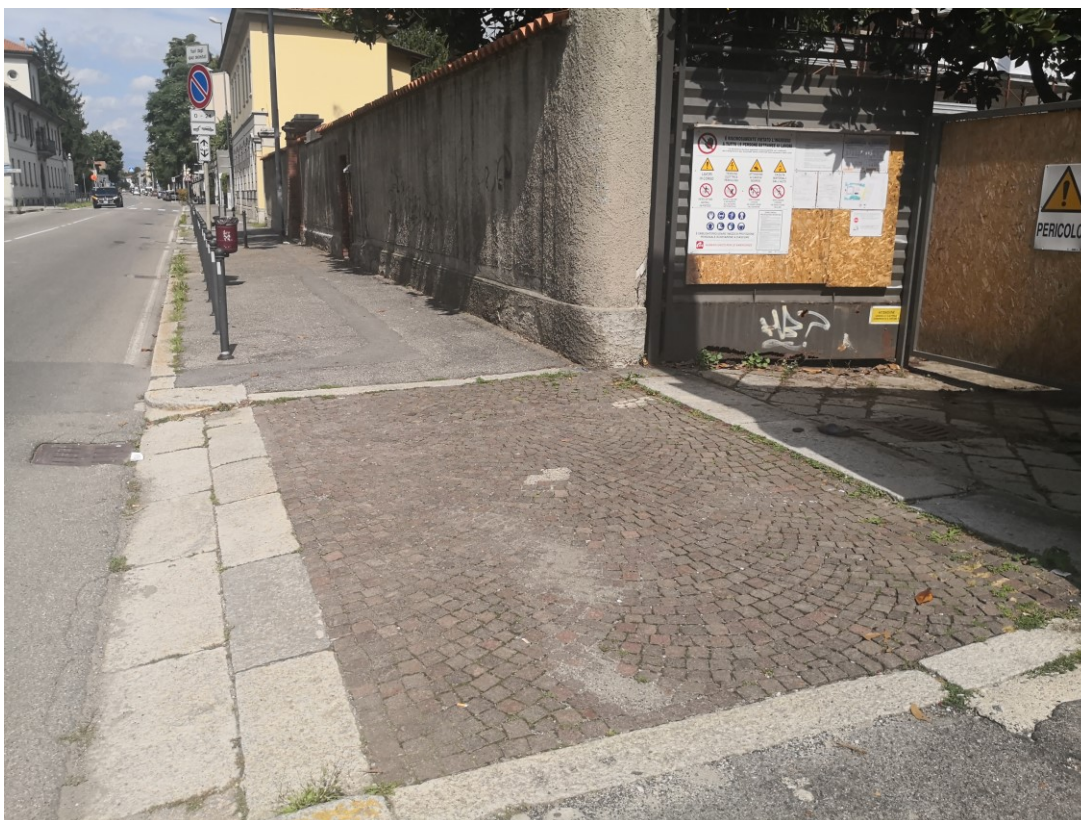
Foto 1: Marciapiede posto lungo via Lecco
