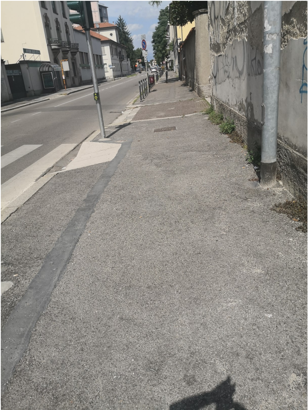
Foto 3: Marciapiede lungo via Lecco
