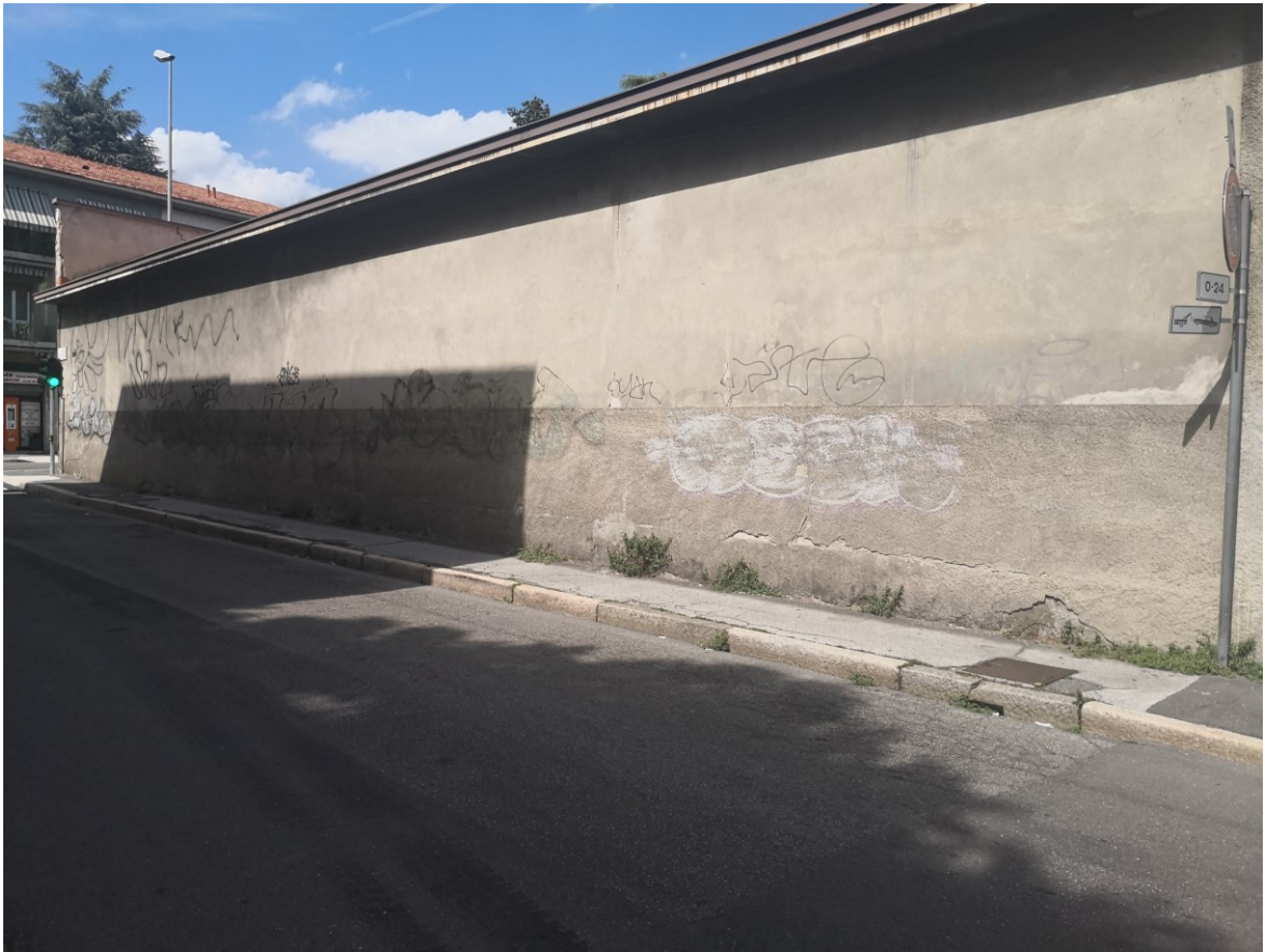
Foto 6: Marciapiede via Merelli
