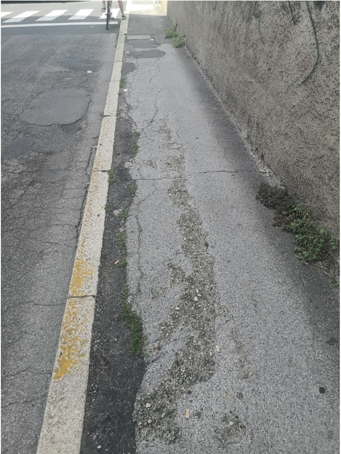
Foto 8: Marciapiede via Merelli
