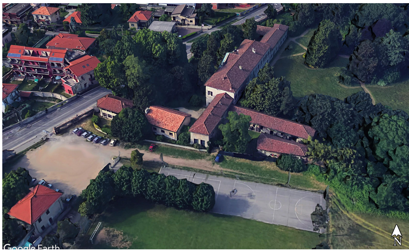
VISTA SUD - Stato Attuale
