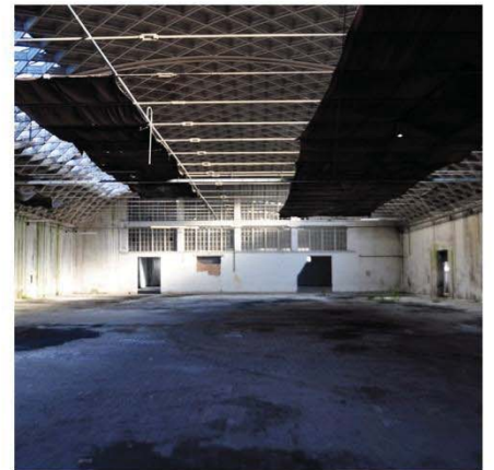
Capannone con copertura ad archi
