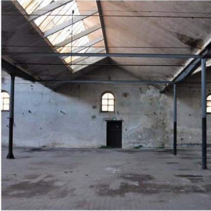
Capannone a shed con pilastri in ghisa
