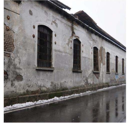
Capannone con lucernario di colmo
