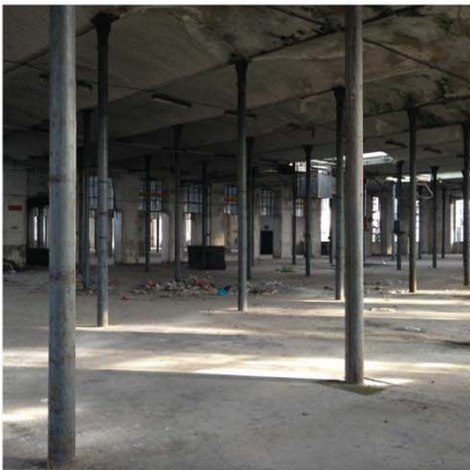
Capannone con voltine a botte
