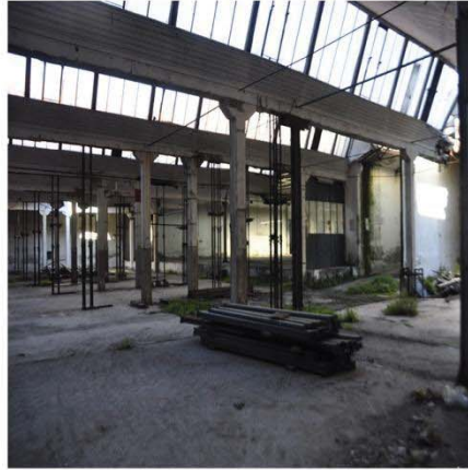
Capannone a shed con pilastri in C.A.
