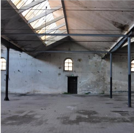
Capannone a shed con pilastri in ghisa
