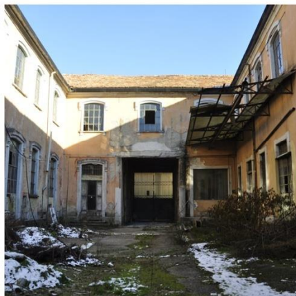
Edificio pluripiano a corte
