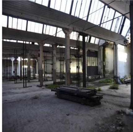
Capannone a shed con pilastri in C.A.
