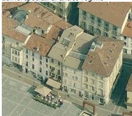
Edifici a schiera
