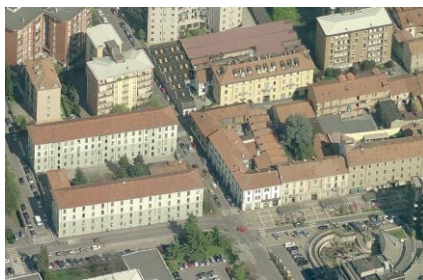
Edifici antichi e di valore testimoniale
