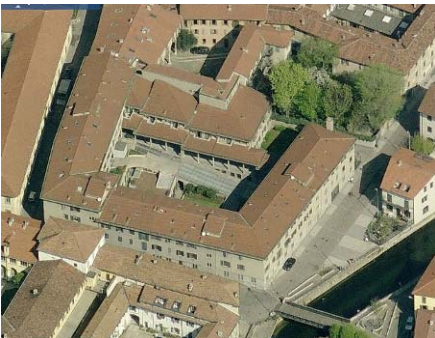
Edifici su sedime antico
