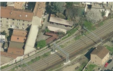
Edifici di intasamento
