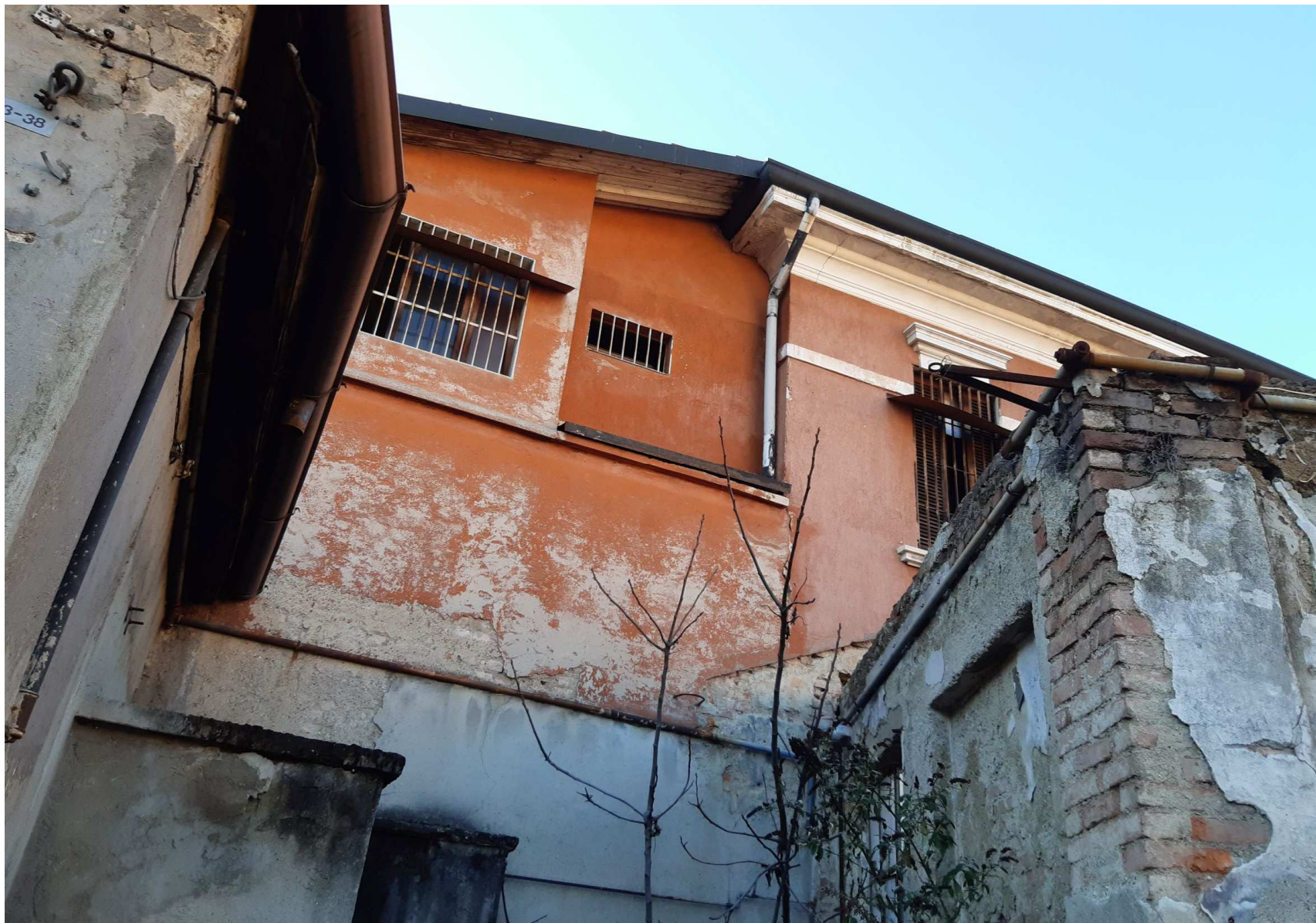
1 – CORPO RESIDENZA-UFFICI DI PROPRIETA' FUMAGALLI VISTO DA PROPRIETA' SANTINA; MURO A CONFINE EST
