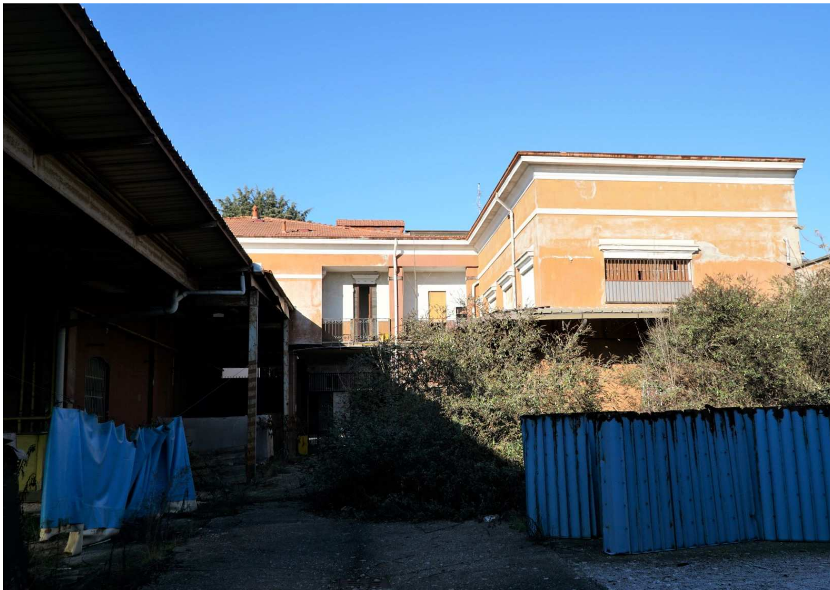
4 – CORPO EST AD USO UFFICIO E ABITAZIONE - VISTA DA SUD
