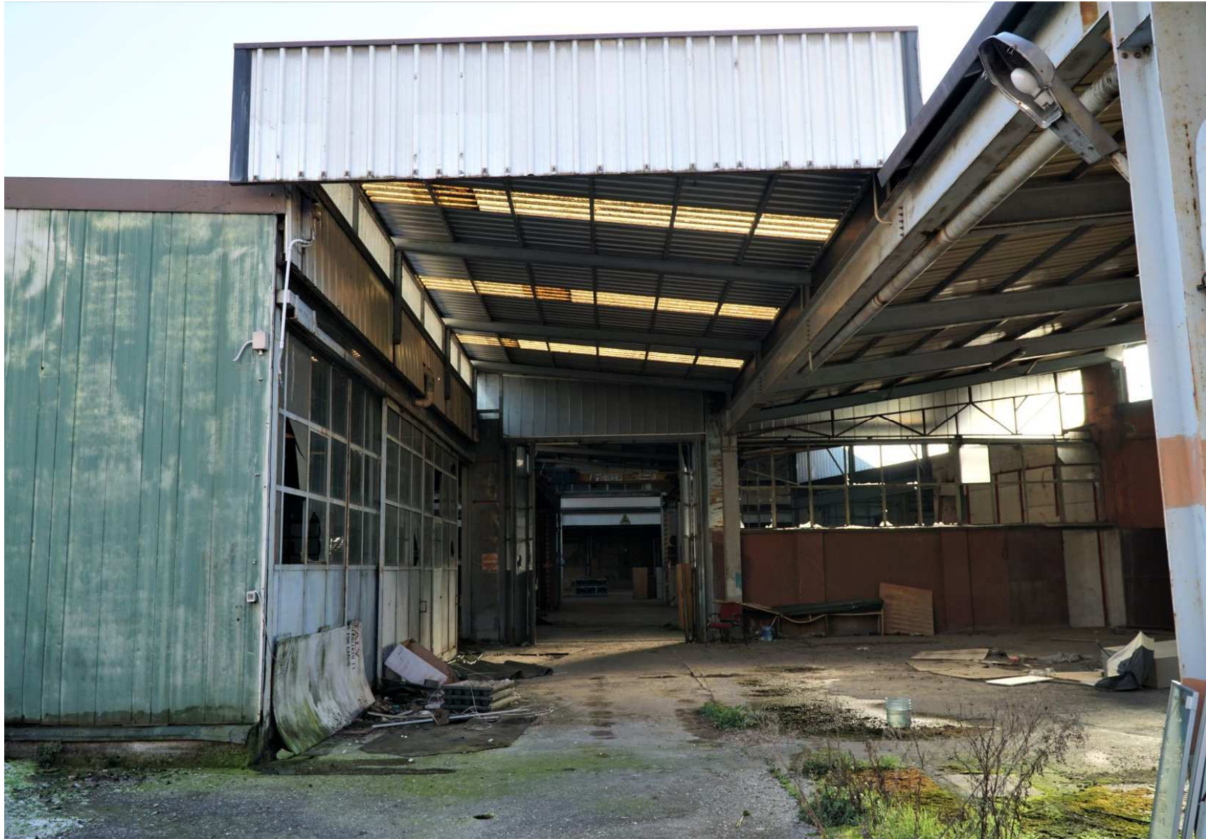
7 – CORPI ARTIGIANALI E TETTOIA - VISTA VERSO SUD
