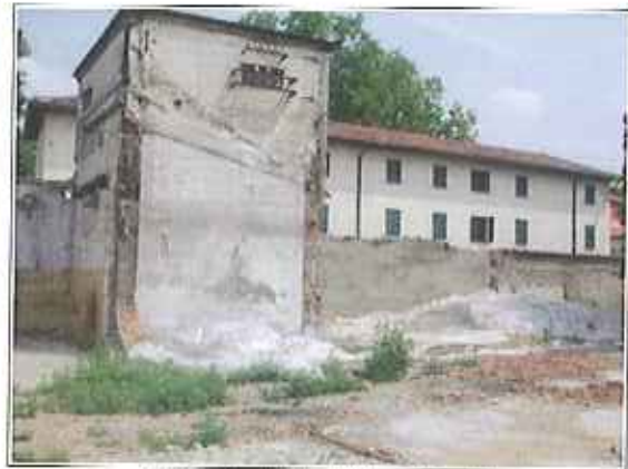
Figura 16 – Vista dell'area di cantiere
