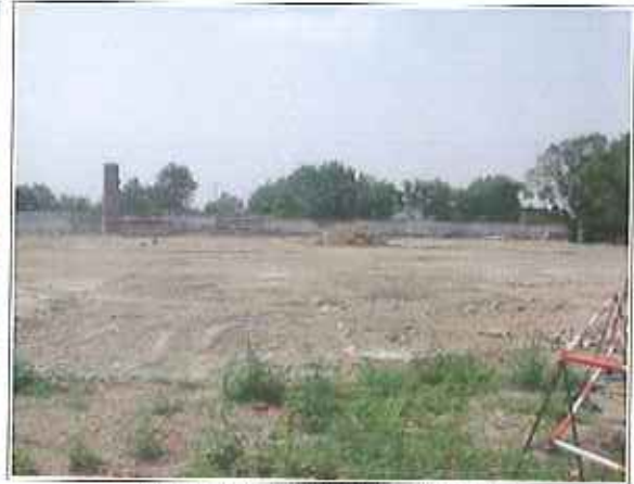
Figura 14 – Vista dell'area di cantiere
