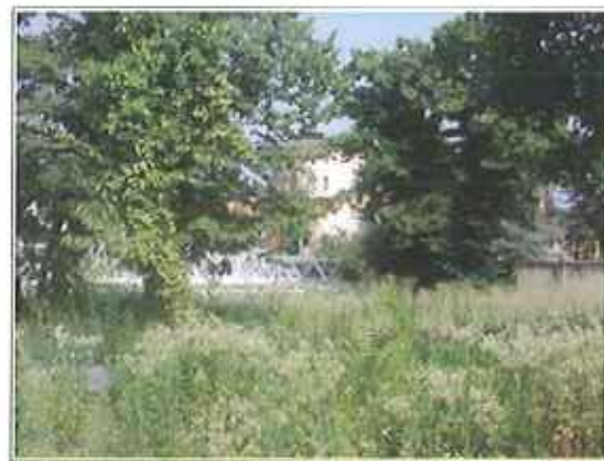
Figura 12 – Vista dell'area di cantiere
