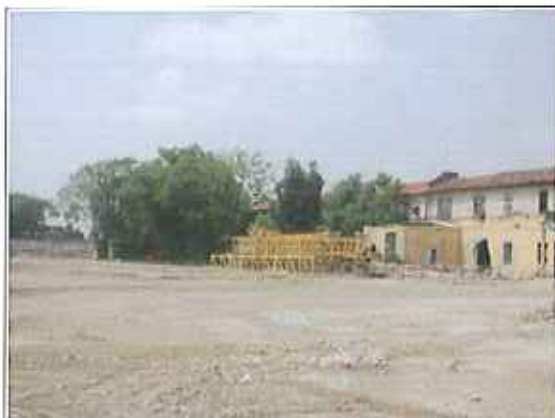
Figura 11 – Vista dell'area di cantiere
