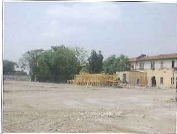
Figura 13 – Vista dell'area di cantiere
