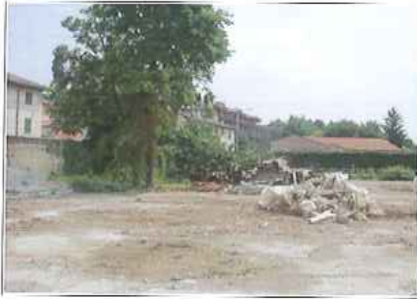
Figura 15 – Vista dell'area di cantiere
