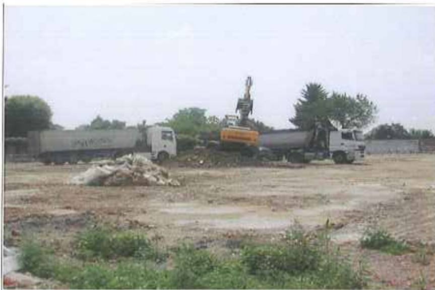
Foto 13 – Cantiere nell'area in esame
