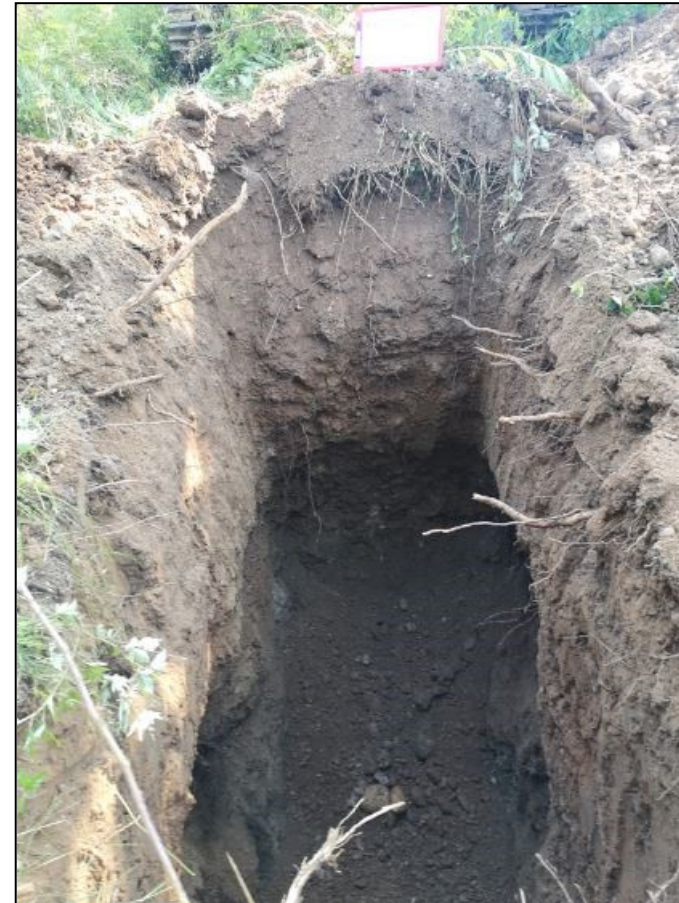
Scavo di trincea T4
