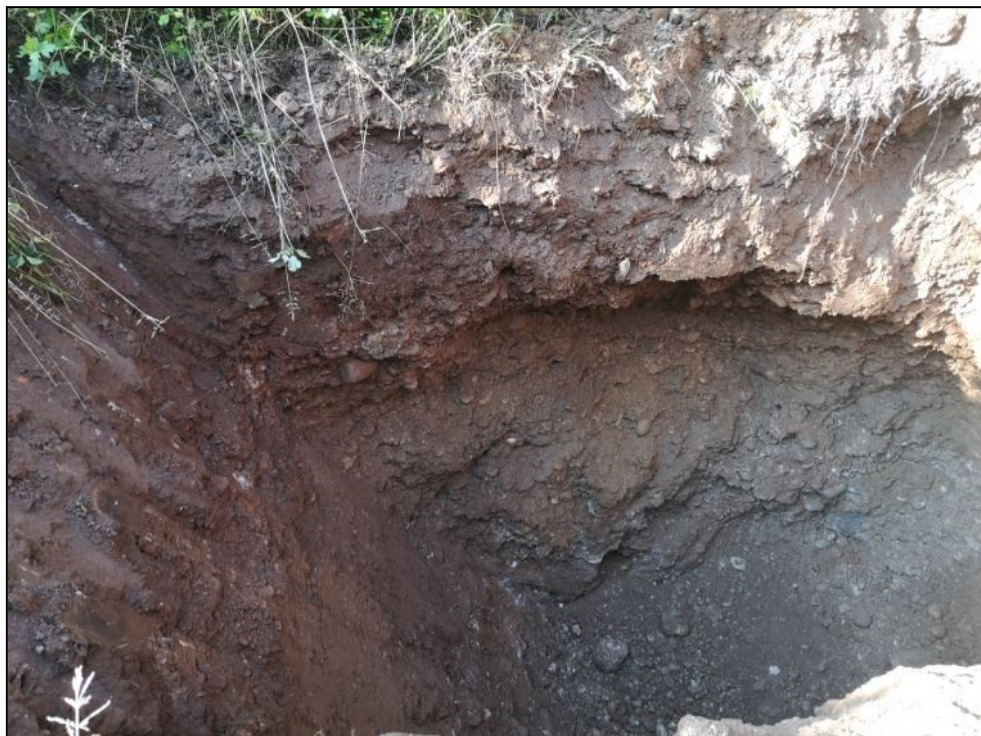
Scavo di trincea T1
