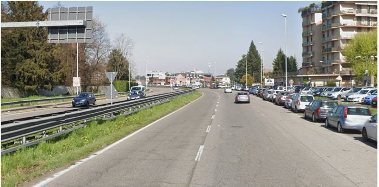
Foto 4 – S4 – viale Elvezia – direzione nord
