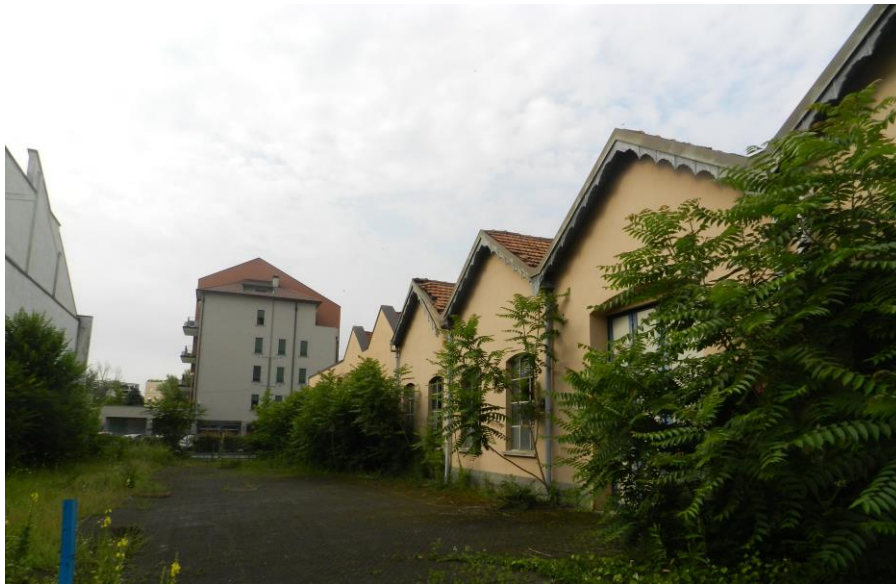
Edificio produttivo fronte est
