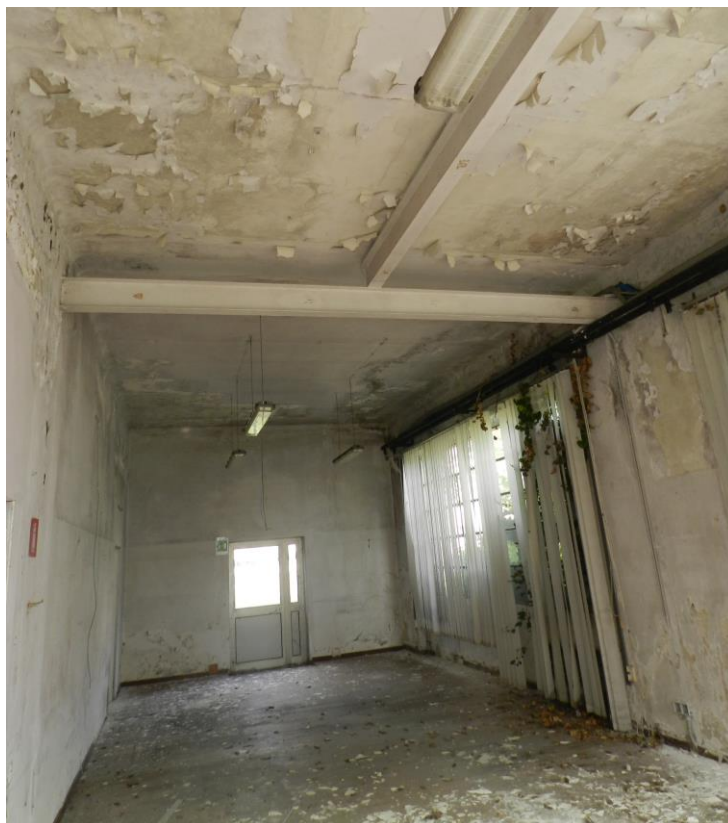
Interno Edificio produttivo a est
