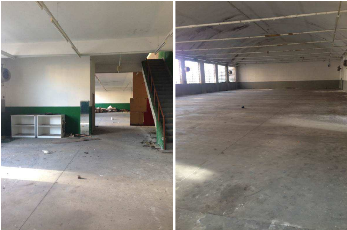
Interno dei capannoni.
