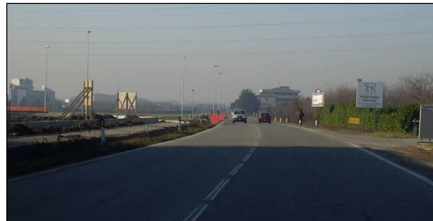
Figura 39 – Pista ciclabile in corso di realizzazione lungo via Monza
