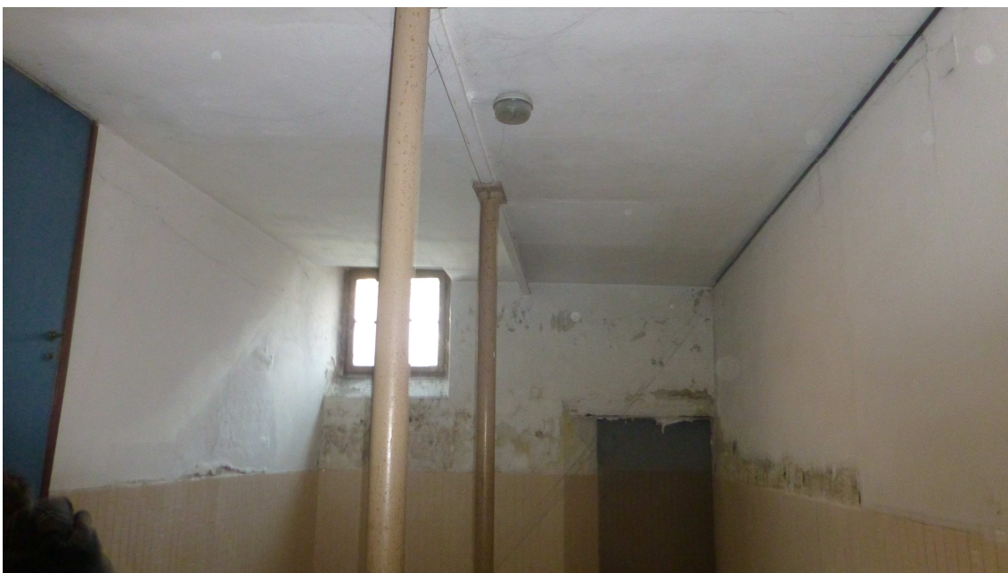
Livello interrato: zona sotto palcoscenico
