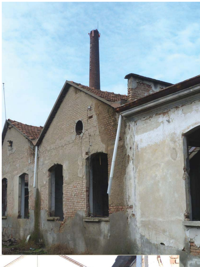
Foto 14 e 15: gli edifici dell'area acidaggio (lato) e, sullo sfondo, quelli adiacenti ("batterie" e "motore diesel")
