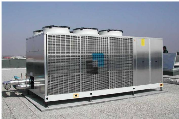
**Fig. 16: Macchina pompa di calore ad aria**
