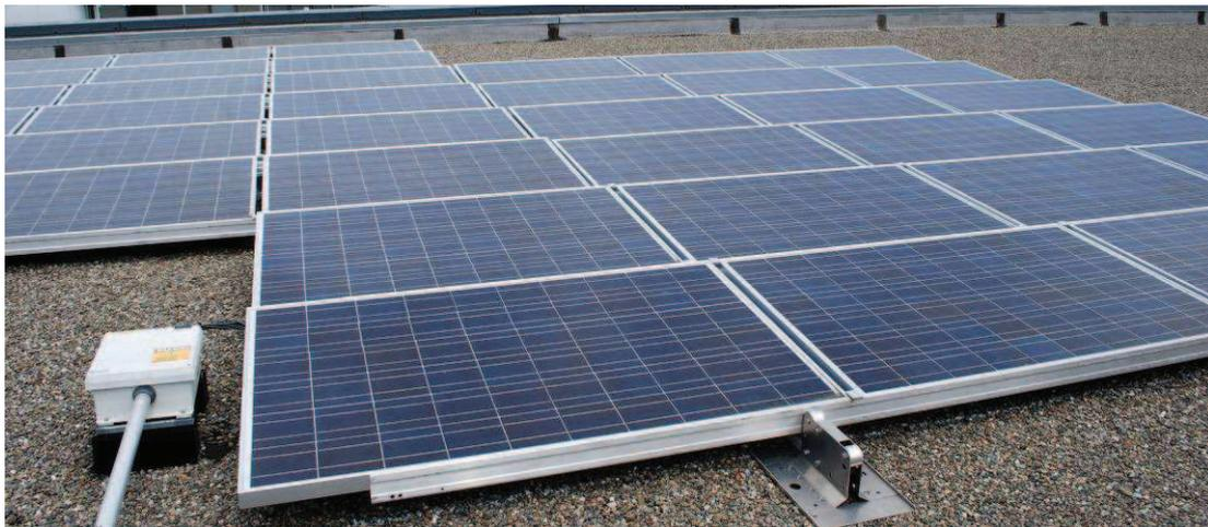
**Fig. 32: impianto fotovoltaico su copertura piana**
