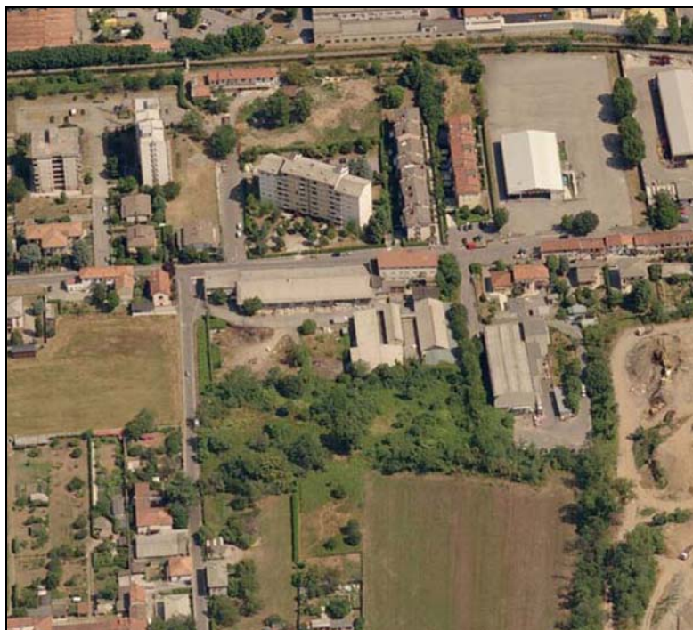
Vista Sud – Stato di Fatto
