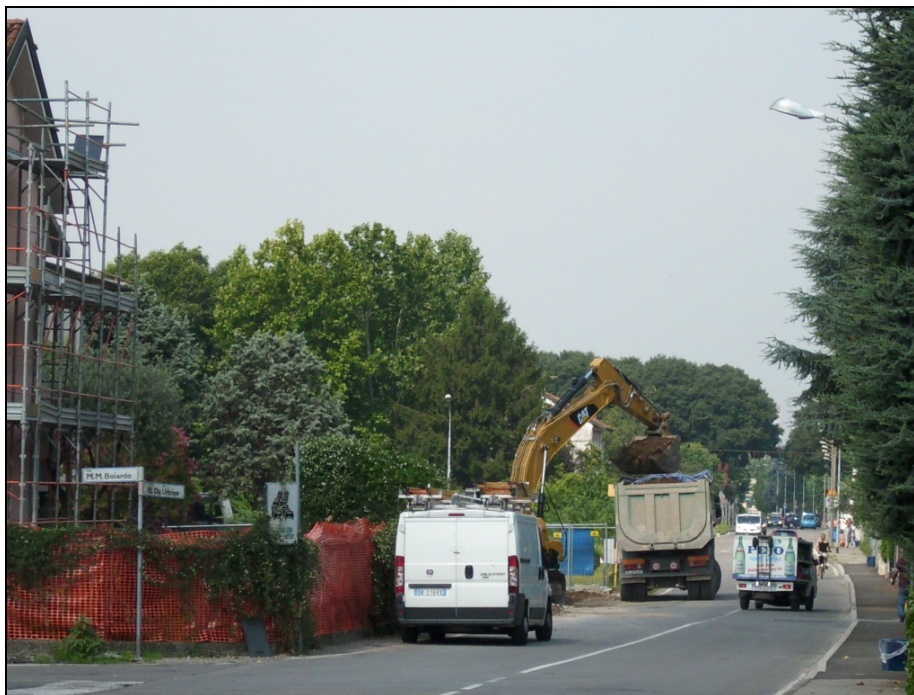
FOTO 4 : Cantiere ad ovest dell'Area
