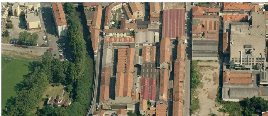
VISTA AEREA DA SUD
