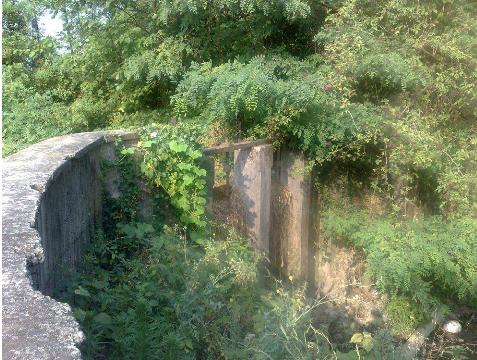
Figura 6.5 - L'imbocco della Roggia Lupa, derivata dal Lambro. Si nota il locale abbassamento del muretto di Via Ghilini.
