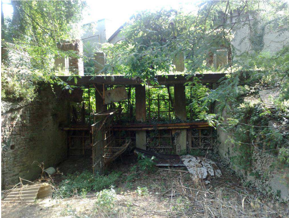
Figura 6.2 - Scaricatore della roggia a Nord di Via Mentana, alla confluenza del Lambretto nel Lambro. Si osserva il totale abbandono dell'opera. L'acqua di piena del Lambro potrebbe entrare tranquillamente da questo manufatto ed invadere il tratto seguente di roggia.
