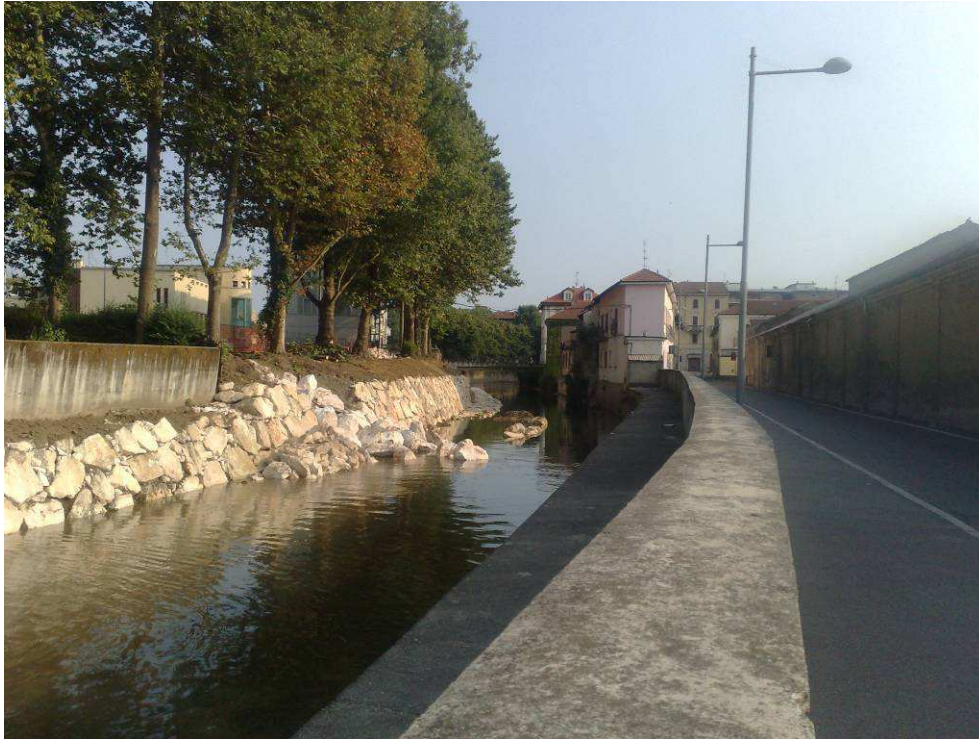
Figura 6.3 - Il muretto lungo Via Ghilini. Si nota sulla sponda destra la scogliera in fase di realizzazione.
