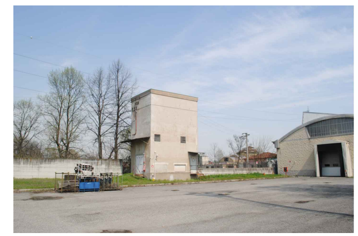
Foto 04 esterno edificio G
