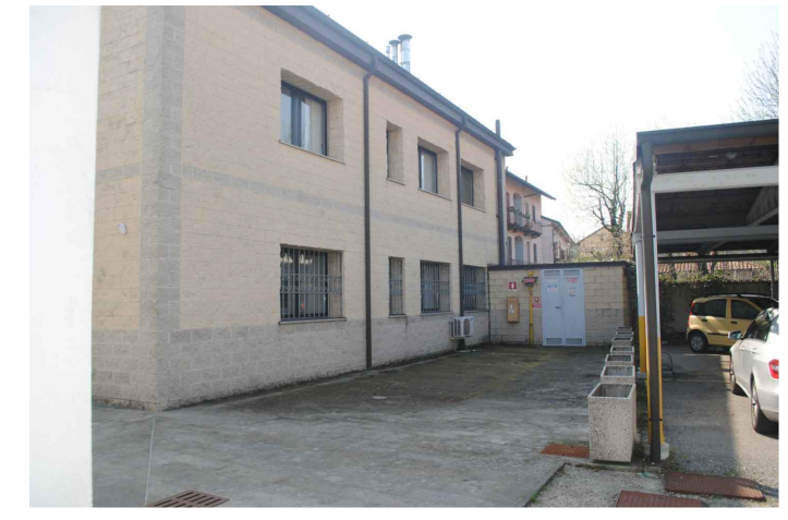
Foto 06 esterno edificio H
