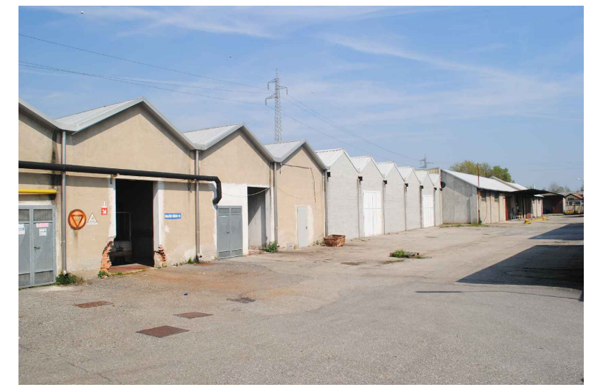
Foto 10 prospetto sud edificio F
