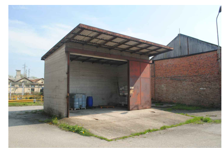
Foto 05 esterno edificio E
