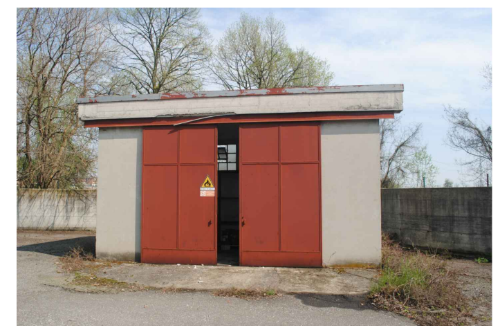
Foto 01 esterno edificio D
