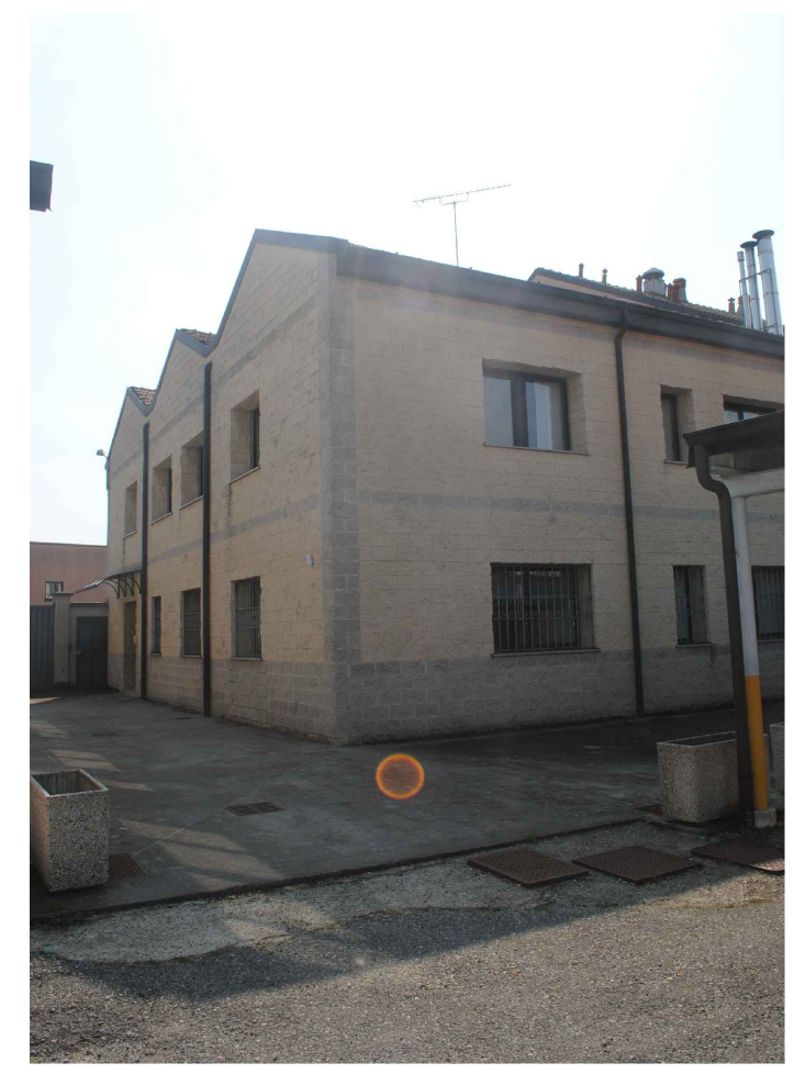
Foto 07 esterno edificio H
