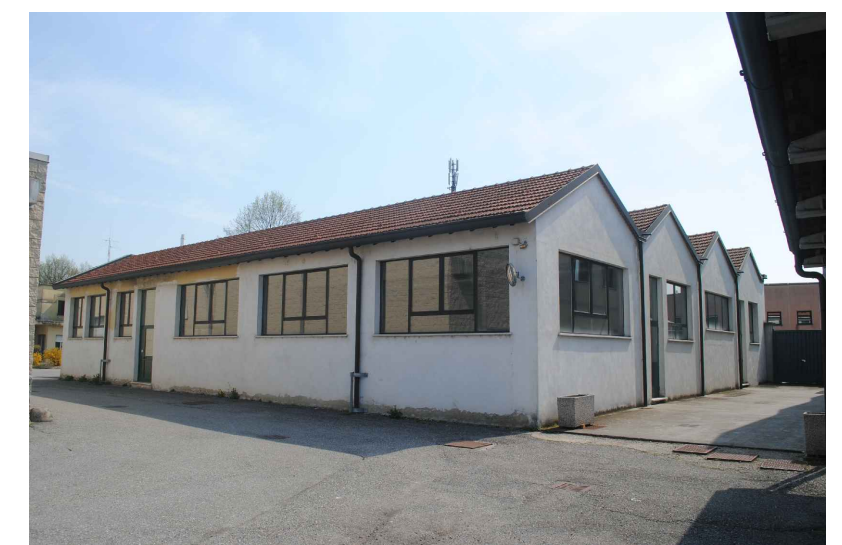
Foto 08 vista nord-ovest edificio I
