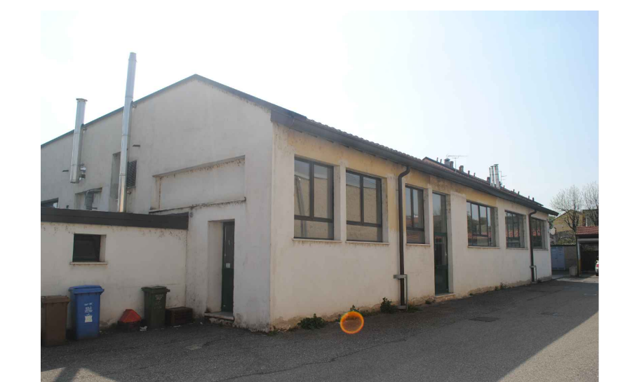
Foto 09 prospetto nord-est edificio I
