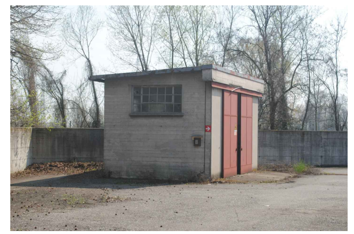
Foto 02 esterno edificio D
