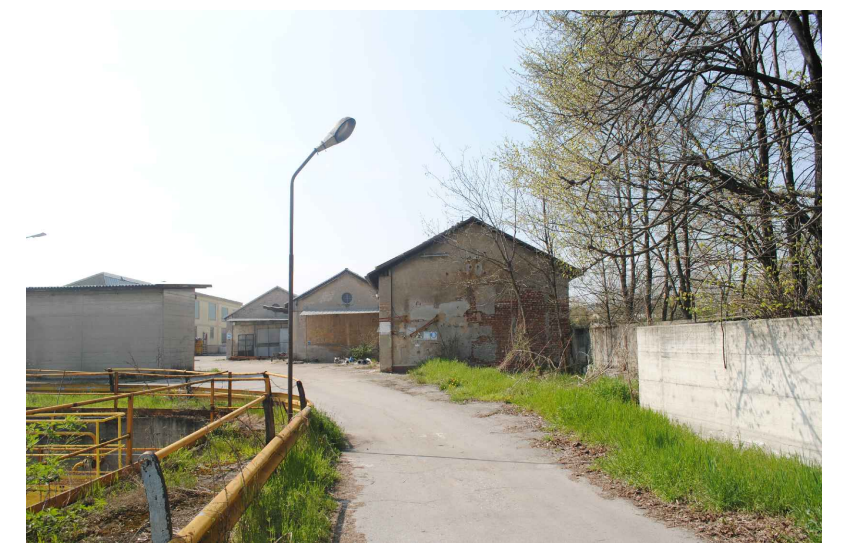
Foto 11 prospetto est edificio F
