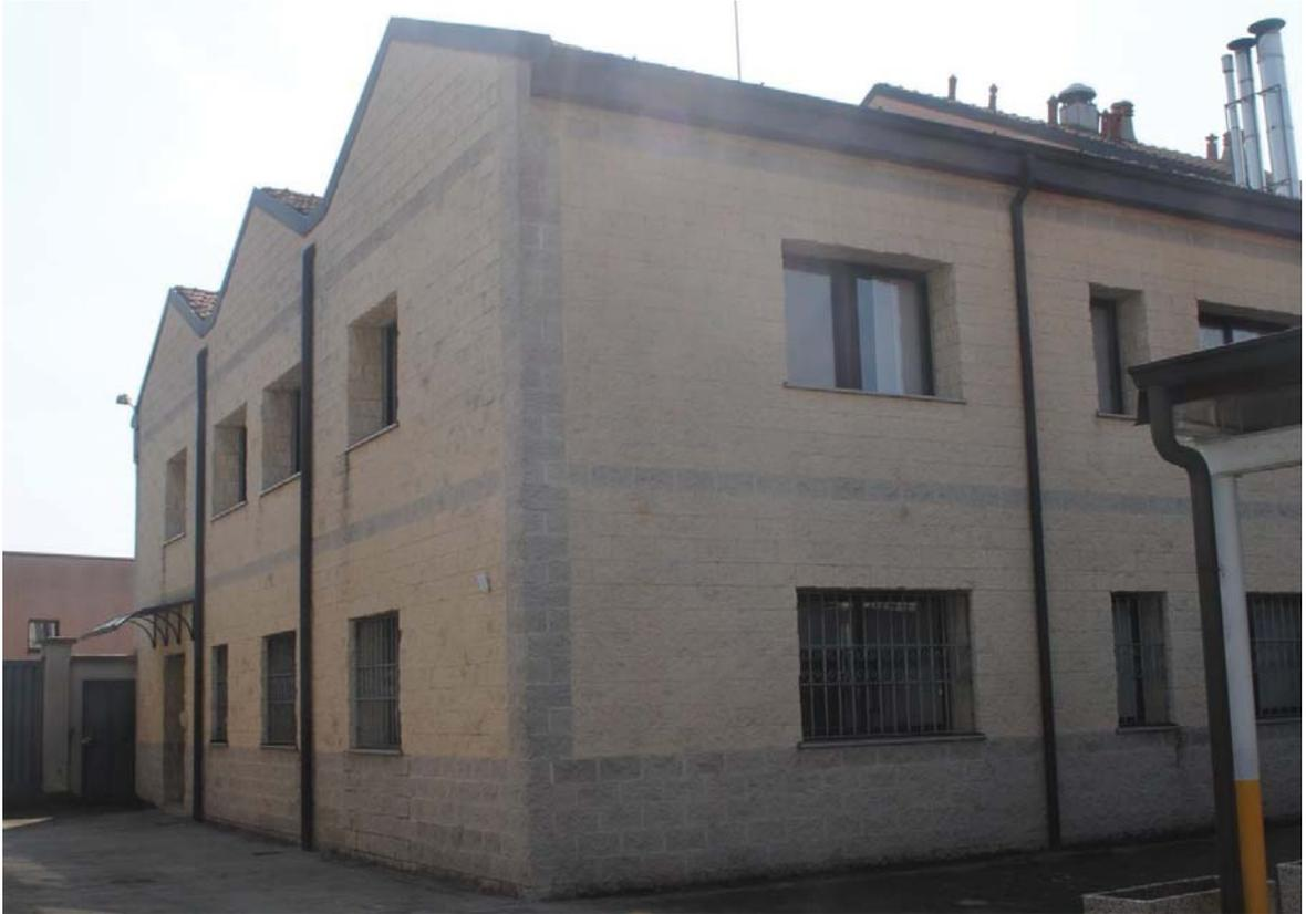
Fabbricato "I" destinato a mensa, di un piano fuori terra è realizzato mediante una struttura mista con pilastri in ferro e travi in cemento armato, con copertura a falde.
