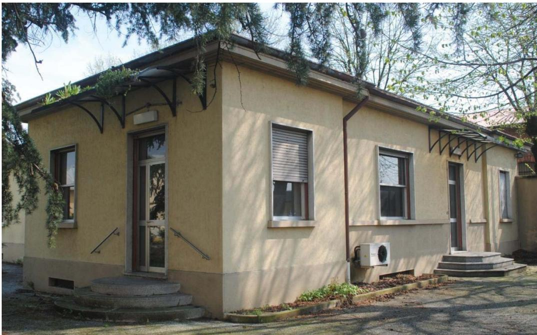
Nell'area che si stende dal corso del fiume alla via Monte Grappa, è collocato l'edificio "O" destinato allo stoccaggio dei materiali, di un piano fuori terra, con altezza interna di mt. 6,70. Si tratta di un edificio con struttura in muratura e muri in mattoni faccia a vista, copertura in cemento e sovrastanti tegole in cotto.
