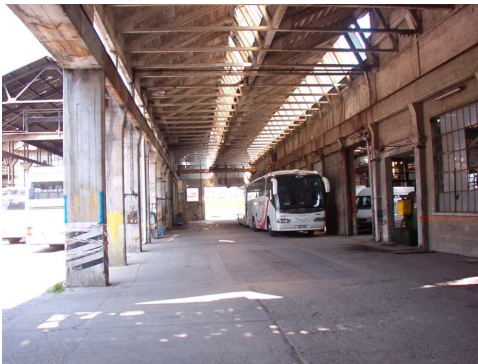
Foto 4 – ex fabbricato sede produttiva: area transito
