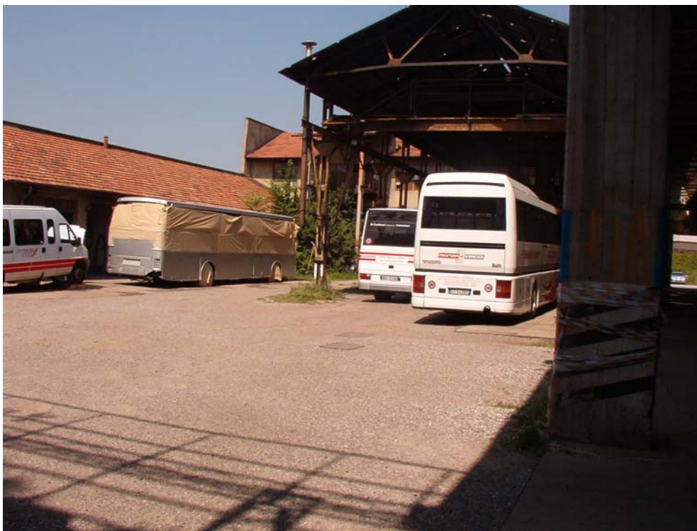
Foto 3 – ex fabbricato sede produttiva: piazzale interno e tettoia
