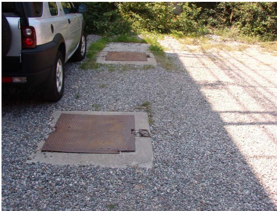
Foto 10 – passo d'uomo cisterna combustibile
