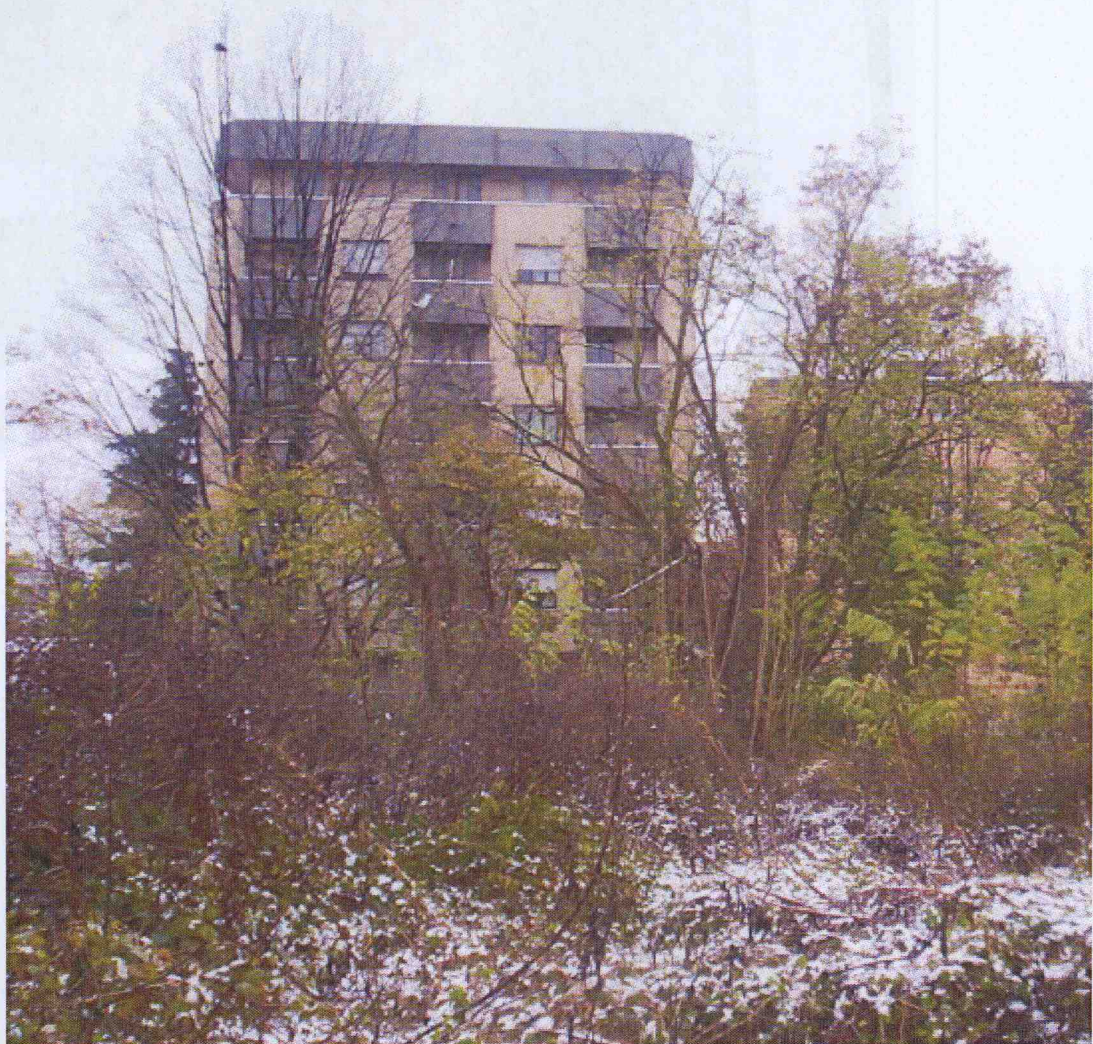
Area delle opere in progetto, vista verso Sud
