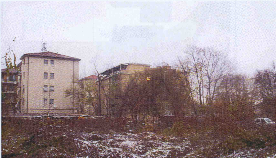
Area delle opere in progetto, vista verso Nord-Est
