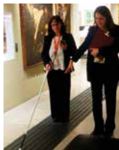
Percorso tattile plantare con bastone dotato di connettività
