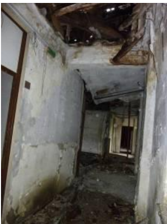
Cedimento solaio
