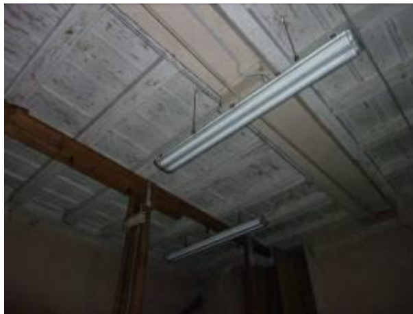
Provvisorio rinforzo di solaio
