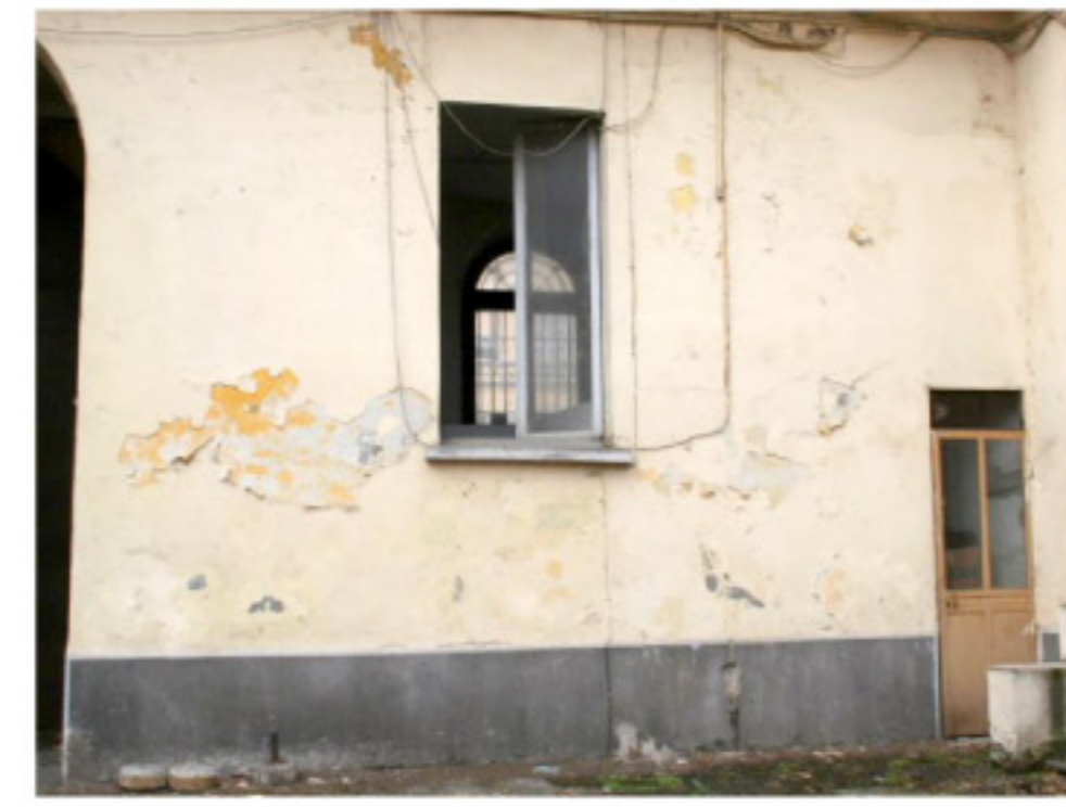
Particolare dell'intonaco realizzato con più strati sovrapposti su base di muratura in mattoni. I rappezzi e i rifacimenti successivi, sono stati realizzati prevalentemente con malta cementizia più volte tinteggiata. La mancanza di coesione tra gli strati dei rappezzi, la differente tipologia di traspirabilità e permeabilità ai sali ha causato rigonfiamenti e distacchi generalizzati causando un degrado complessivo di tutto l'intonaco.
