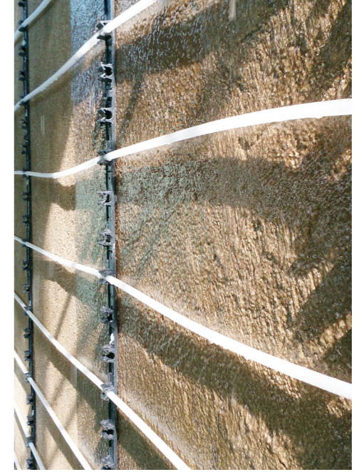
4. Lavaggio della facciata per eliminare tracce di polvere e migliorare l'adesione dell'intonaco
