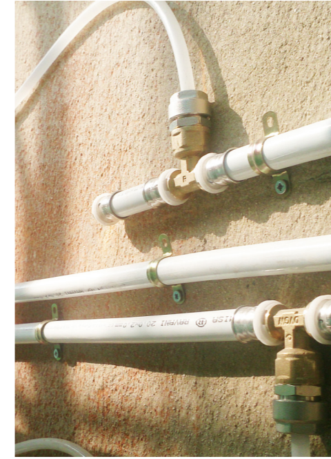
3. Installazione circuiti idraulici ed elettrici secondo progetto. Collegamento alla centrale termica di progetto. Primo collaudo. Pressione 2,5 volte quella di esercizio per 48 h
