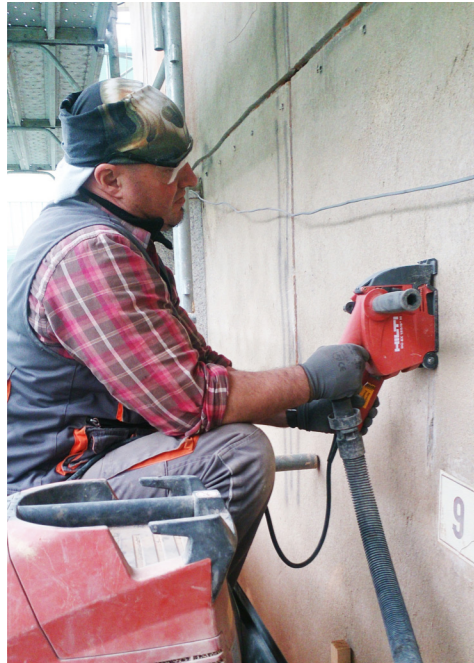
1. Realizzazione tracce per alloggiamento sonde; posa corrugati e chiusura tracce con malta
