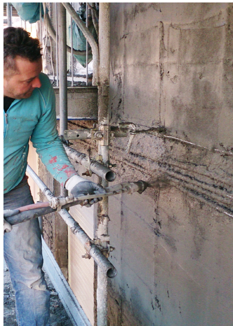
5. Intonacatura a macchina con termointonaco TFP301; staggiatura a piombo. Tassativamente intonacare con impianto a pressione
