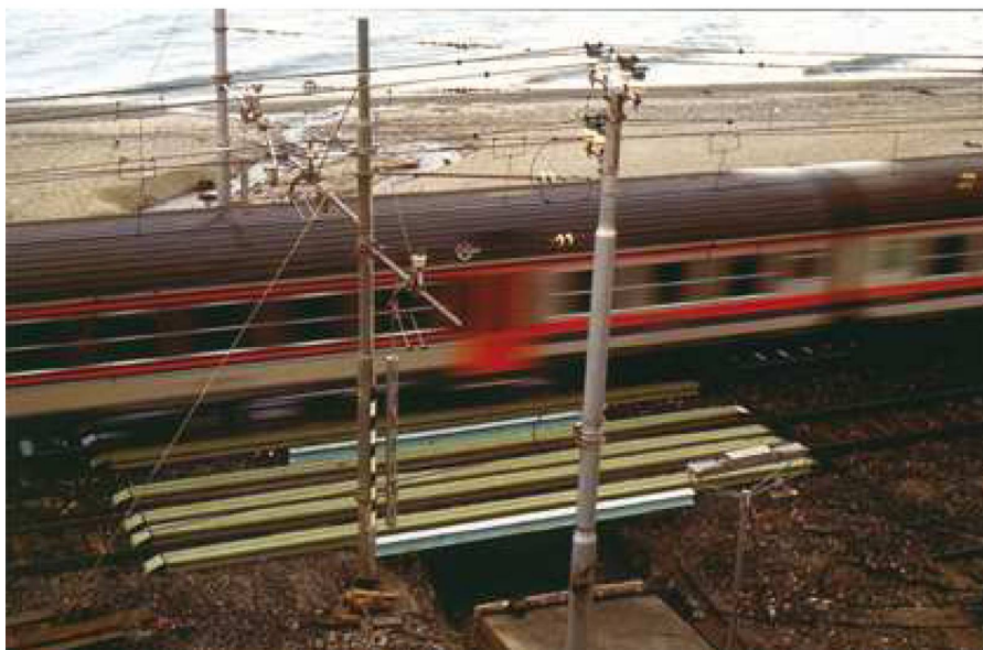
PONTE ESSEN IN ESERCIZIO
